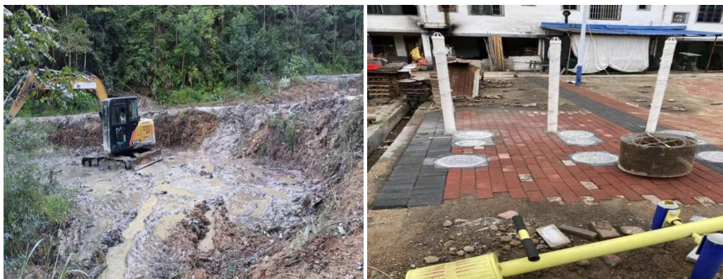
图85、86：开展村级人居设施提升工程
