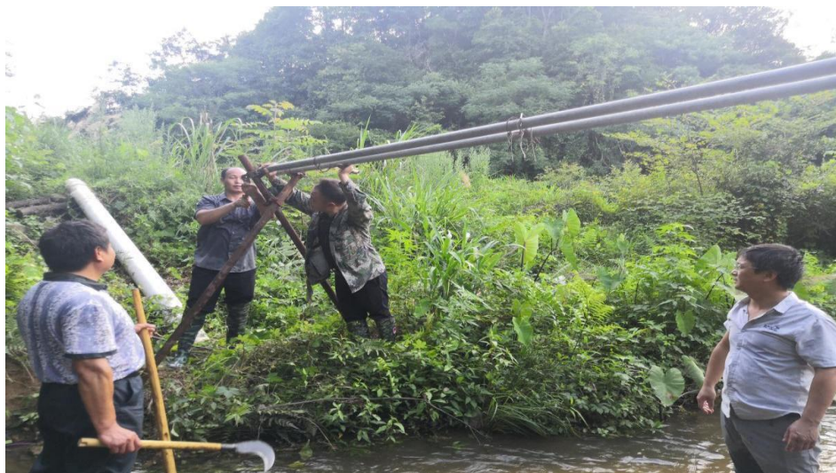
图 83：驻村工作队帮助维修灌溉水渠
