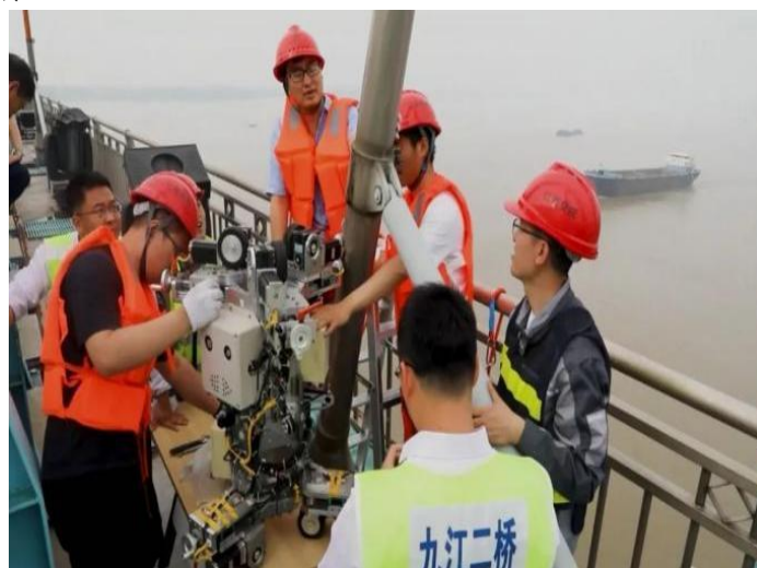
图 2-2 江西交通职业技术学院 03 专项科研项目进行桥梁检测
