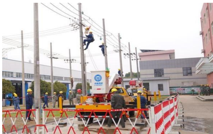
图 2-6 江西电力职业技术学院为供电公司员工开展带电作业现场模拟教学
